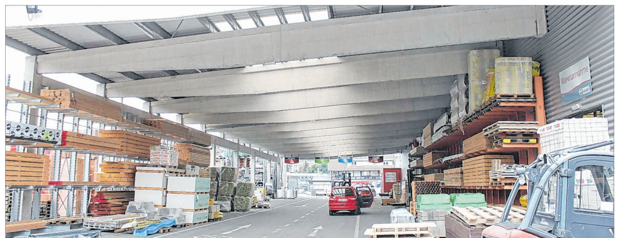
Die Drive-in-Arena sorgt für eine schnelle Abwicklung. „Rein, raus, fertig“, bringt es Uwe Zoll auf den Punkt. Kunden haben die Möglichkeit, Material und Baustoffe direkt und überdacht abzuholen.
