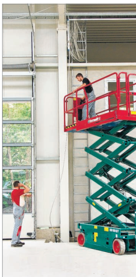
Die Mitarbeiter sind auch in luftiger Höhe im Einsatz.
